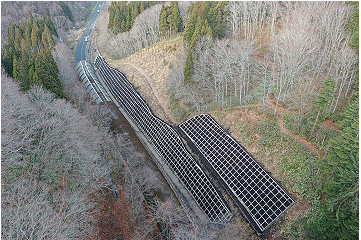
空中撮影による災害防除外一連の工事現場（福島町桧倉工区工事現場）
